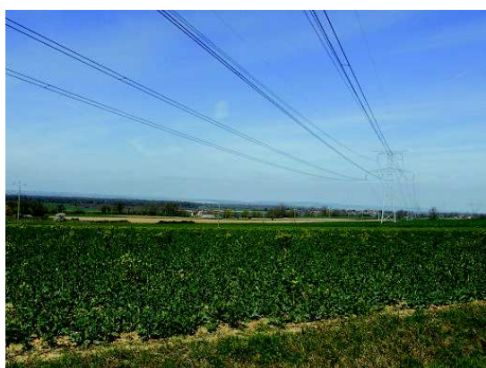
Lignes très haute tension
